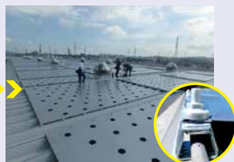
③ 金具を増締めの後、防錆用キャップを取付けて完了
