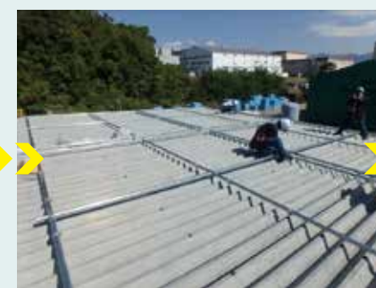
② 鋼材でシートを固定する枠組みを設置
