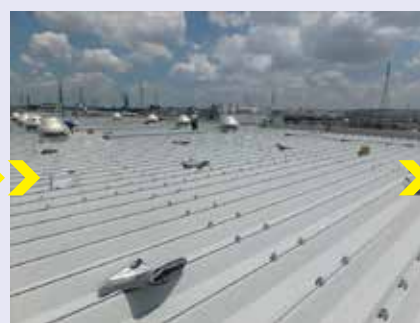
② シートを広げ、金具に締付けて取付
